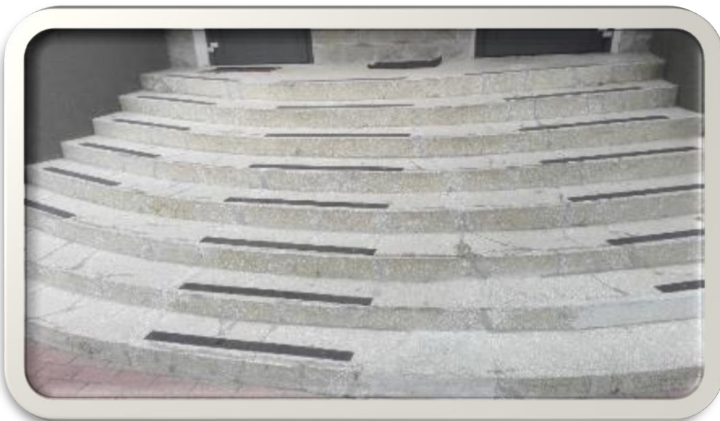
Fot. 9 wyremontowane schody wejściowe w ZSTZ w Radzyminie
