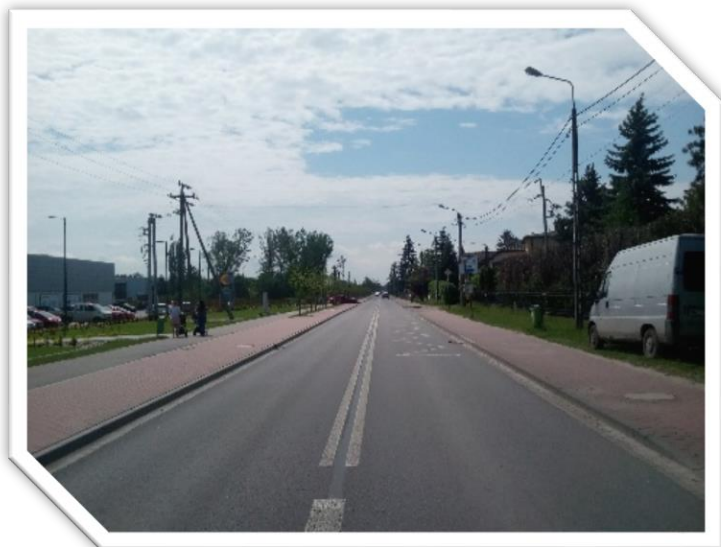
Fot. 35 remont ul. Napoleona w Kobylce
