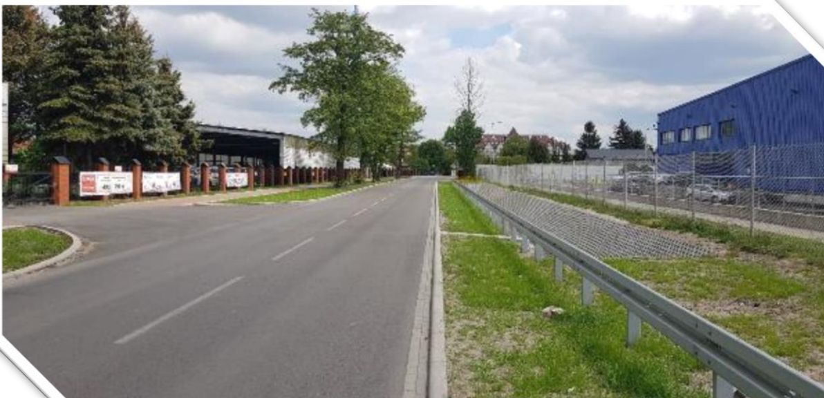
Fot. 46 ul. Drewnicka w Ząbkach
