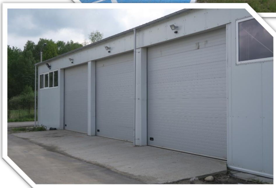
Fot. 1 nowa siedziba Wydziału Inwestycji i Drogownictwa w Zagościńcu
