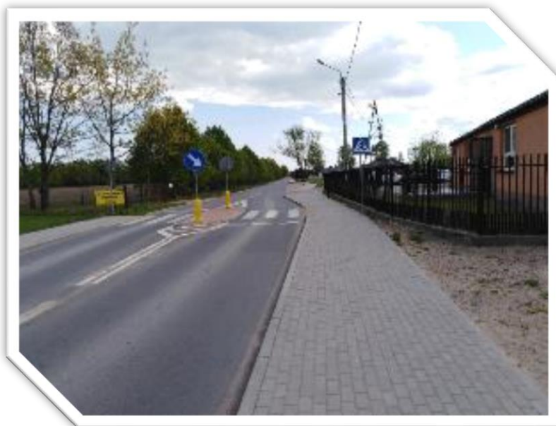
Fot. 41 budowa chodnika i zatoki autobusowej w DP 4324W w Chajętach gm. Dąbrówka
