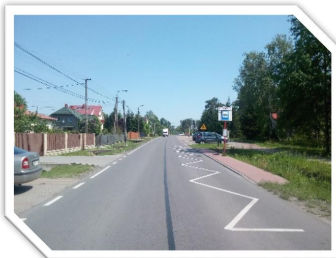
Fot. 34 remont ul. Boryny w Helenowie
