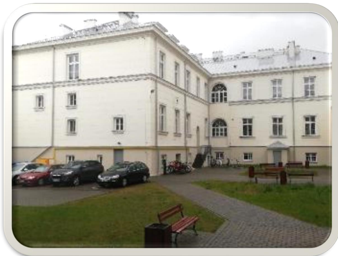
Fot. 11 LO Radzymin, elewacja i dach
