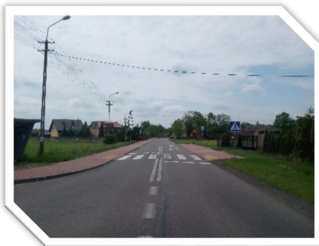
Fot. 32 remont drogi Mostówka - Ręczaje Polskie
